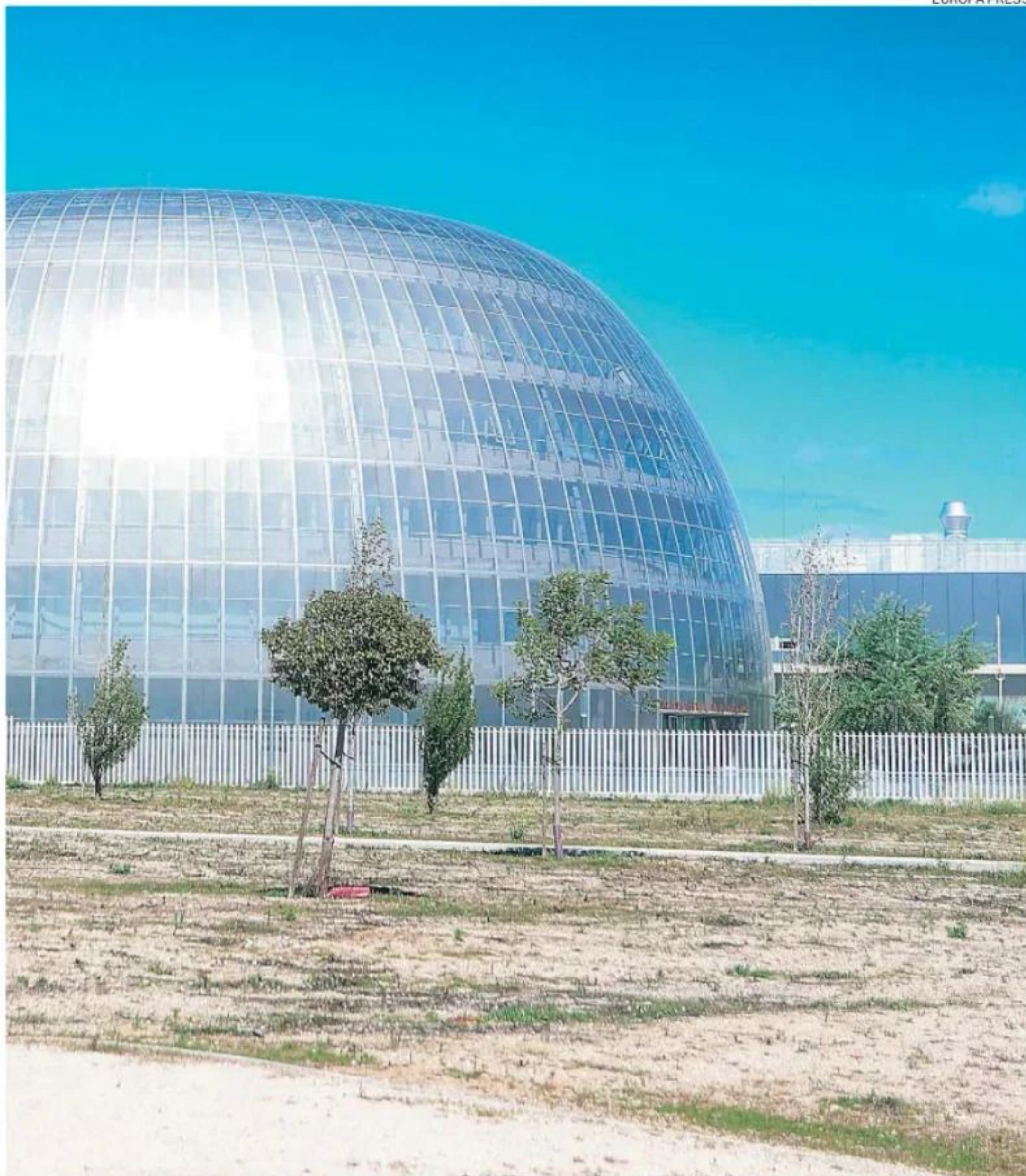
Los trabajos para la Ciudad de la Justicia se iniciarán en mayo de 2025
