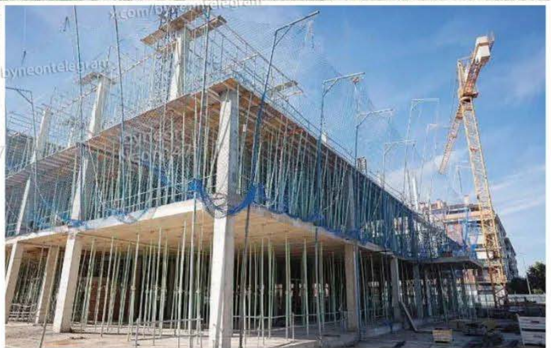
Trabajos en el nuevo Palacio de la Justicia de Torrejón
